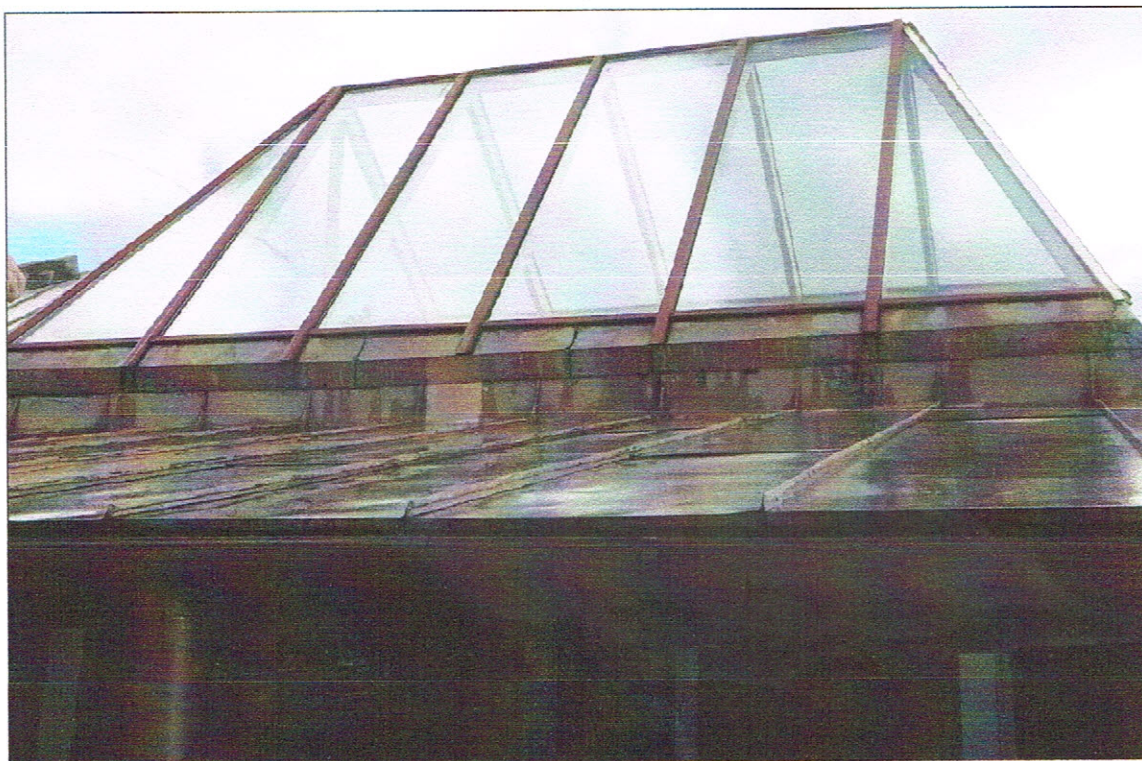
11.fotoattēls. Jumta seguma bojājumi
